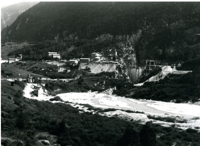
Il cantiere di Ponte Antoi, inizio anni '50. Foto collezione privata Aldo Paulon
